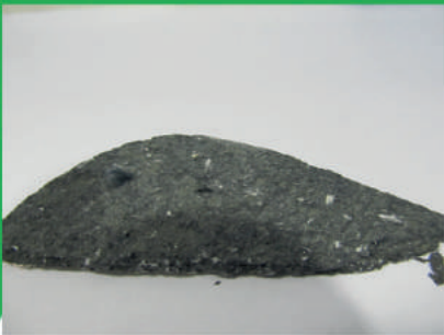
Bruchstück einer Fensterbank aus Asbestzement
